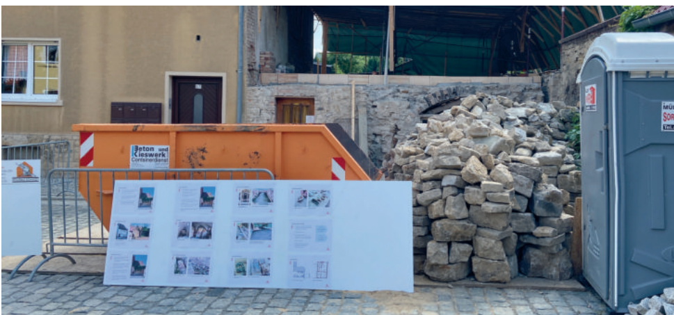
Bauprojekt am Klosterhof 5
