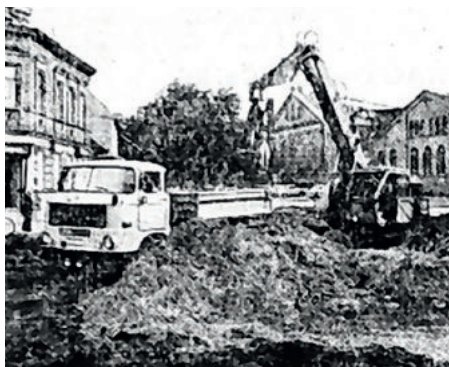
Arbeiten im Juni 1990
