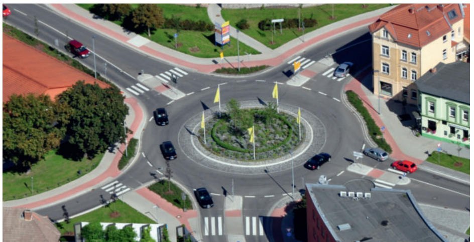
Ein Blick auf die fertige neue Kreuzung im September 2010
