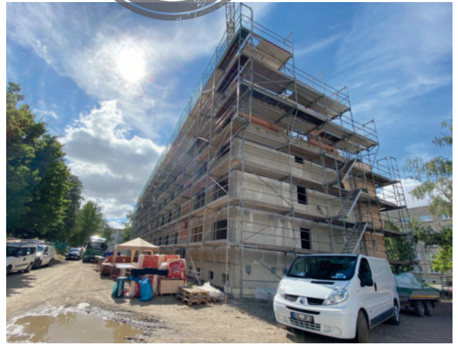
Der Rohbau der Kopernikusstraße 10-16
