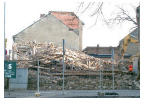
Abrissarbeiten im Juni 2004
