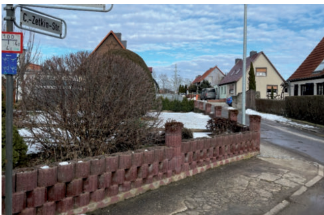
Verlegung eines Schmutzwasserkanals in der Clara-Zetkin-Straße
