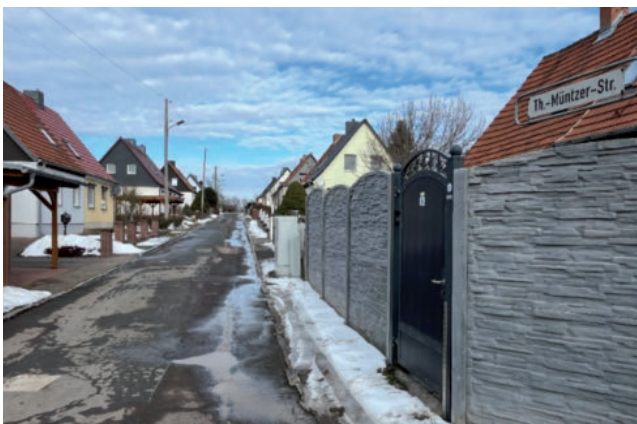
Verlegung eines Schmutzwasserkanals in der Thomas-Müntzer-Straße
