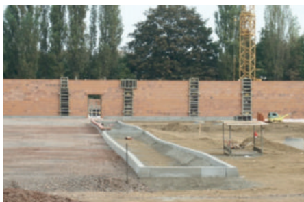
Bauarbeiten für die neuen Parkflächen
