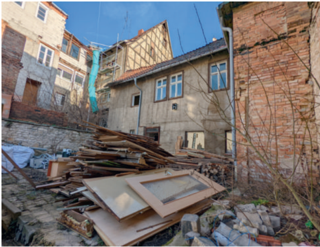
Entkernung Hohe Straße 19 - Hofansicht
