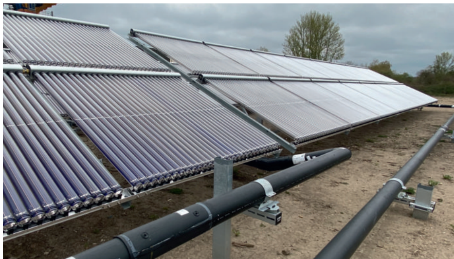
Ihre Stadtwerke bauen derzeit eine große Solarthermieranlage in der Güstener Straße.
