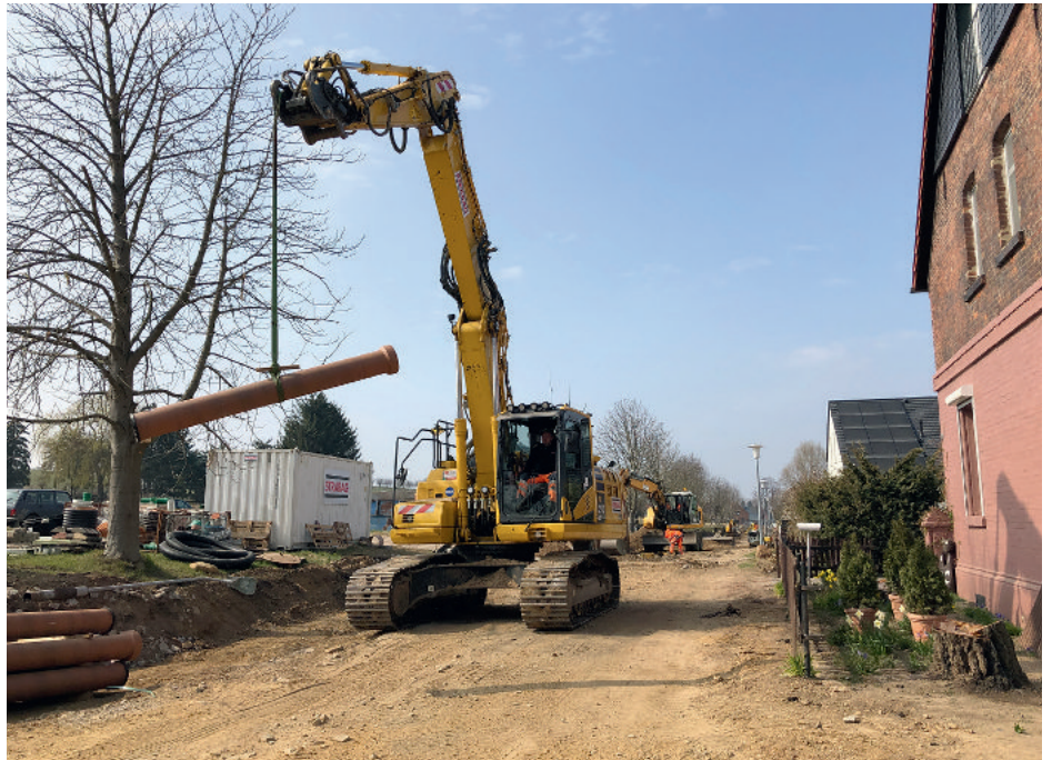
Seit Februar diesen Jahres erfolgt der grundhafte Straßenausbau der Alten Bahnhofstraße in Mehringen.
