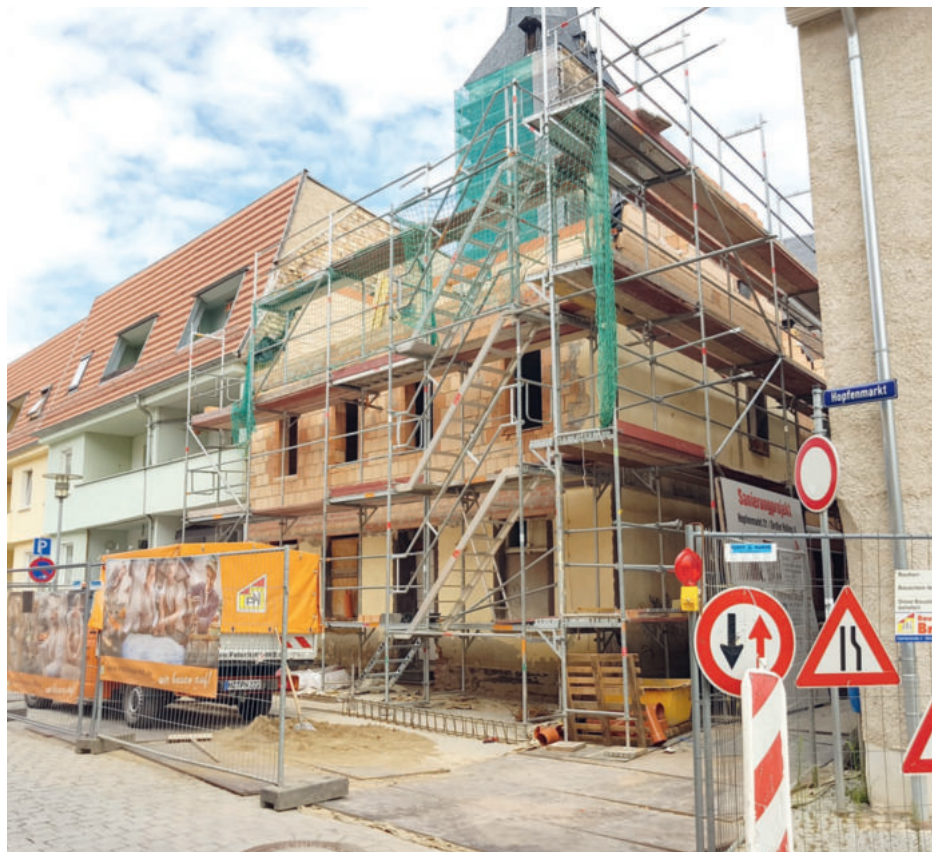
Wohnhaus an der Ecke Hopfenmarkt / Großer Halken während der Bauphase
