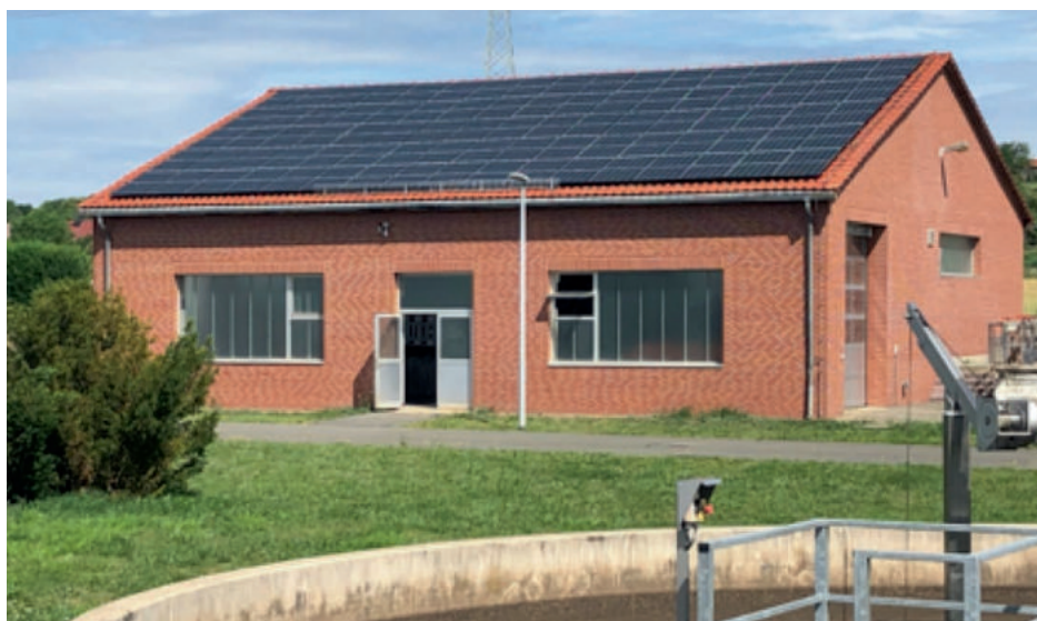
Photovoltaikanlage auf dem Dach des Betriebsgebäudes, die seit dem 1. Juli 2020 Strom produziert.
