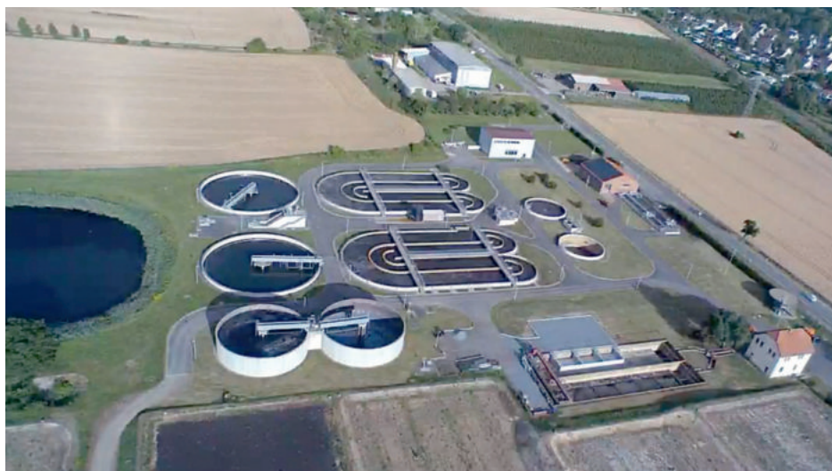
Die Kläranlage von Aschersleben aus der Vogelperspektive
