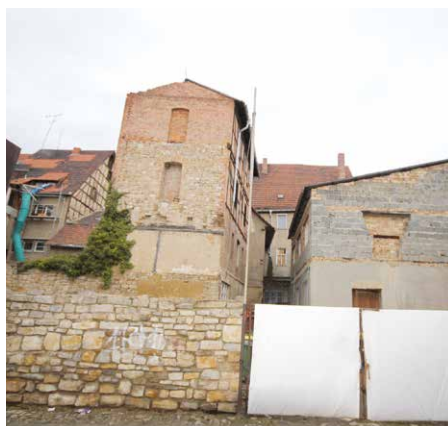
Rückansicht vor dem Abriss
