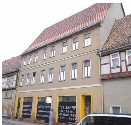
Hohe Str. 20 vor dem Abriss
