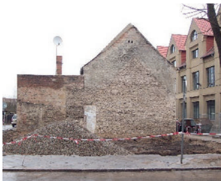
Hinter dem Zoll 12 nach dem Abriss
