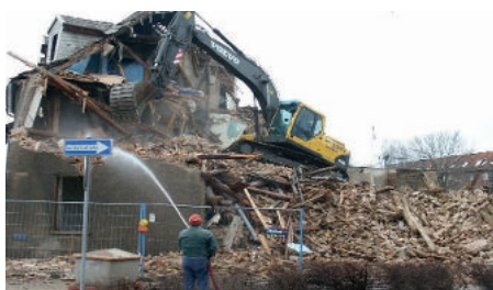
Abriss im Januar 2003
