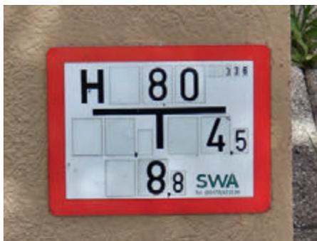
Beschilderung Feuerlöschhydrant (rote Umrahmung) – 4,5 m nach rechts und 8,8 m geradeaus, da befindet sich die Hydrantenkappe (Bild 1)
