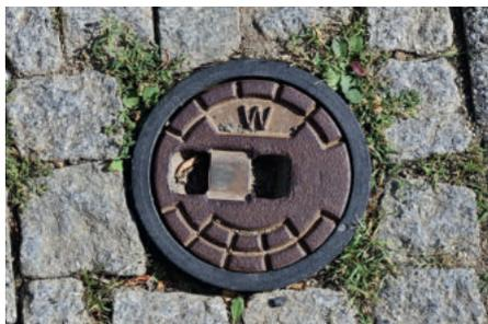
Kappe eines Abstellers für einen Trinkwasseranschluss
