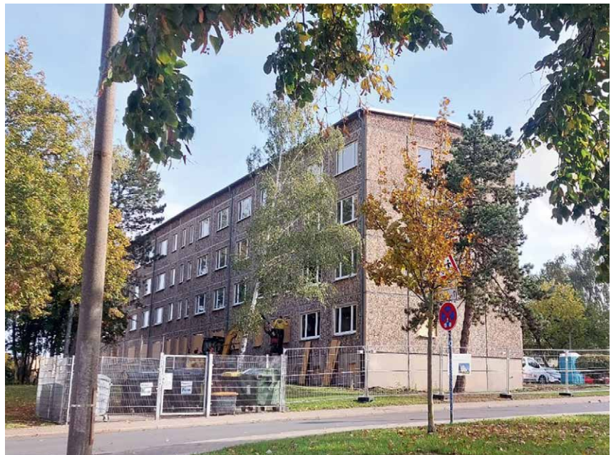
Rückbau eines Wohnhauses – Armstrongstraße 33-39
