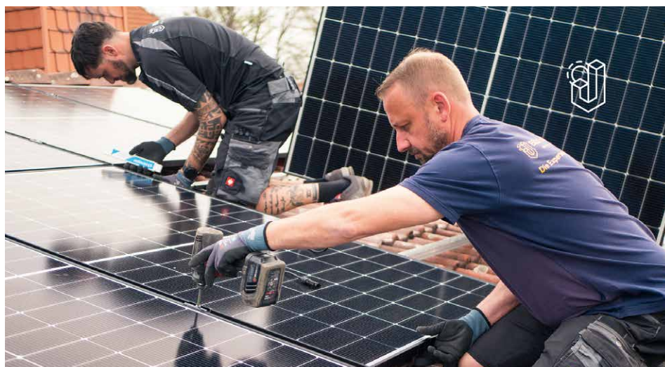
Mitarbeiter der beEnergy Group bei der Montage auf dem Dach
