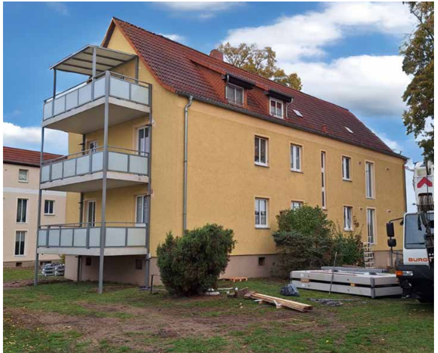
Neue Balkone für die Klopstockstraße 52 und Lessingstraße 33–35
