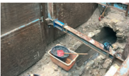
Einblicke in den Mischwasserkanal
