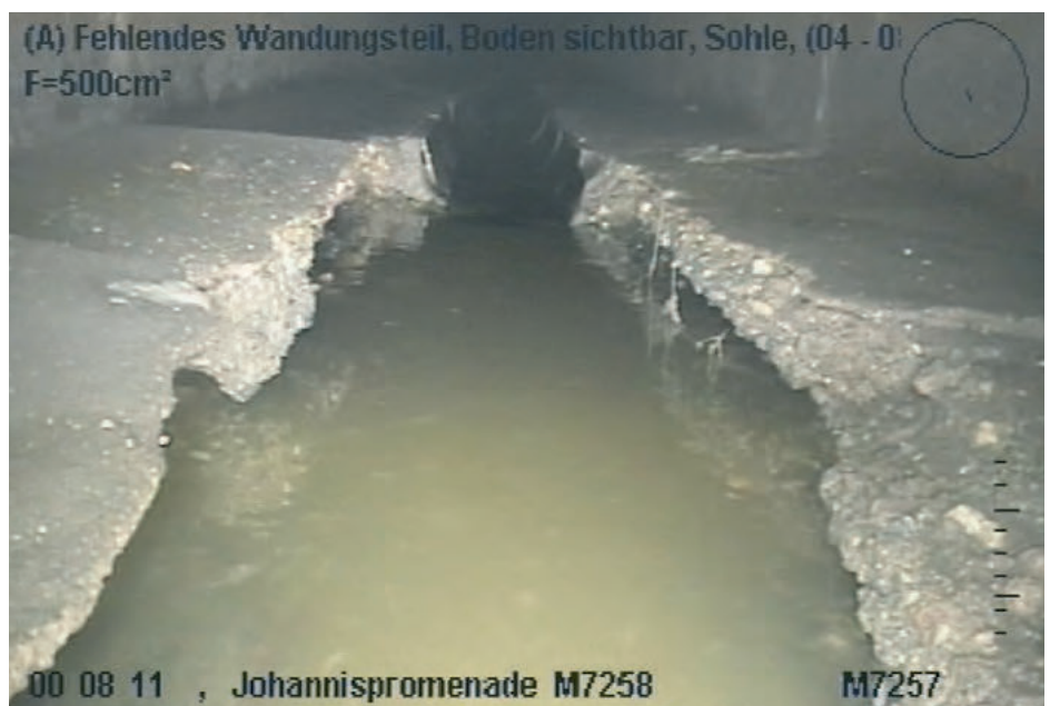
Ausspülungen an der Fließsohle
