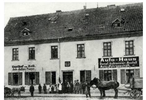
Der „neue“ Zoll in der Krügerbrücke
