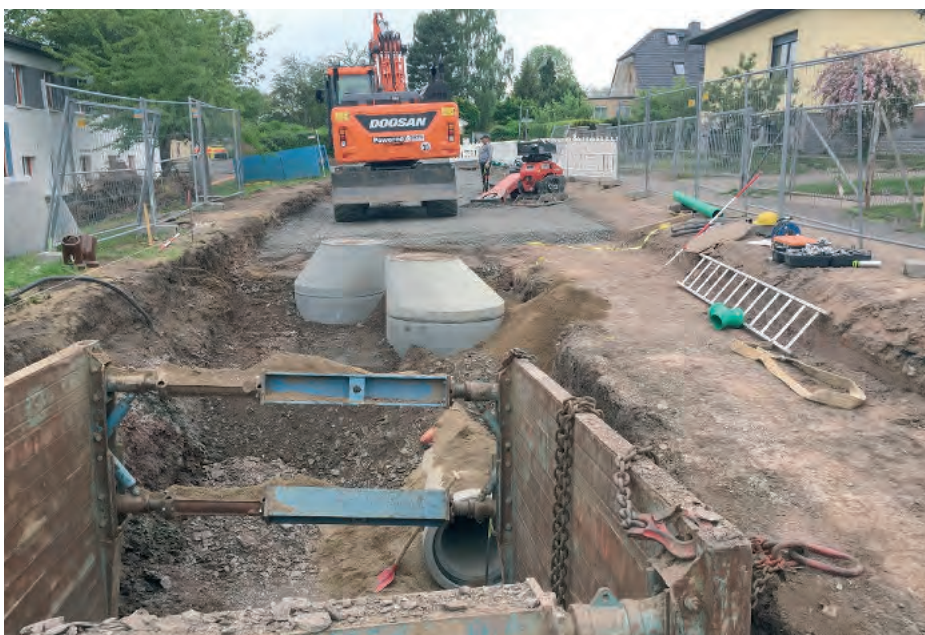
Wie im Bild zu sehen, wird nach der Kanalverlegung und Setzung der Schächte mit einer Rüttelplatte der Unterbau des Lerchenwegs verdichtet. In den nächsten Wochen soll hier der Asphalt aufgetragen werden.
