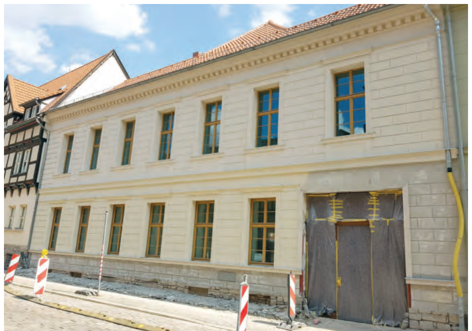
Das Gerüst ist abgebaut und lässt einen ersten Blick auf die neue Fassade zu.
