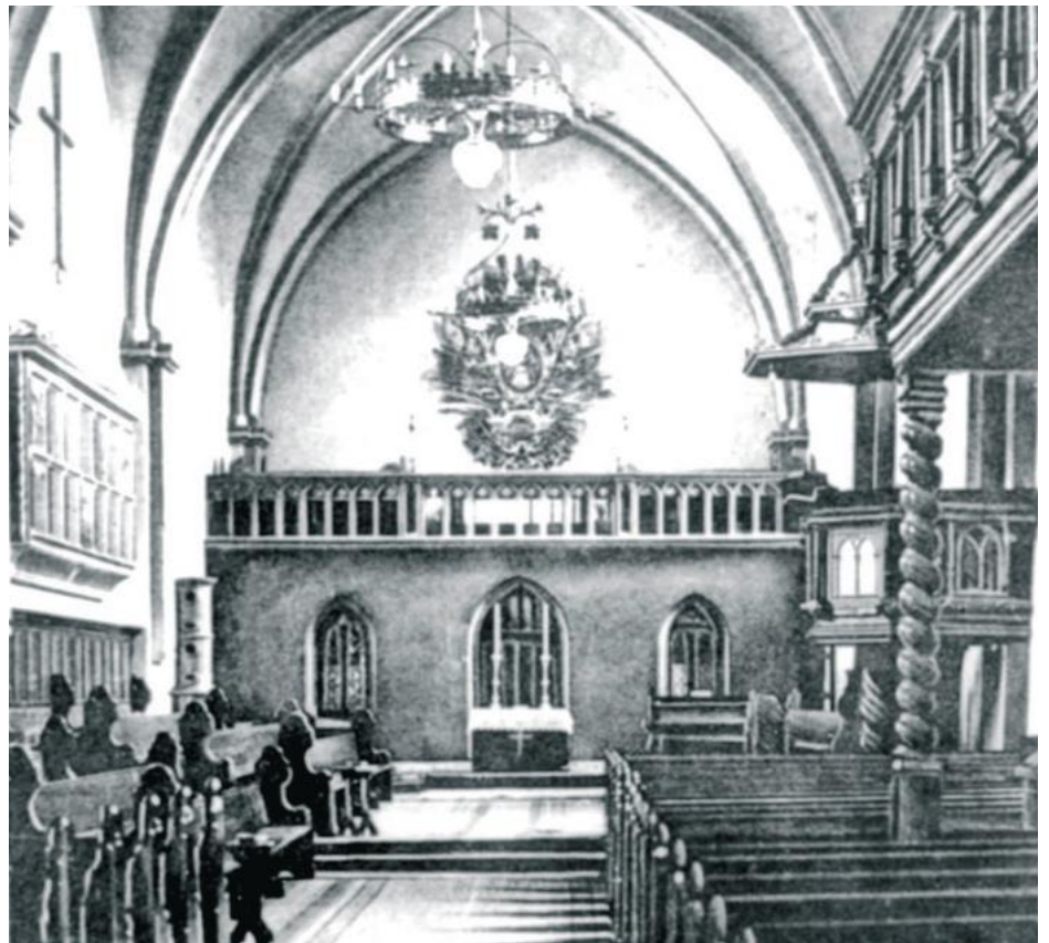
Ostwand vor dem Einbau der Zwischenwand
