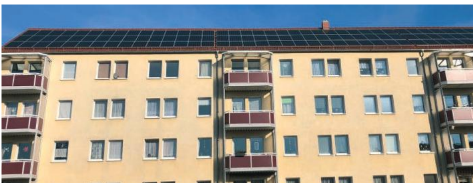
Die neue Solaranlage auf dem Dach der Bahnhofstraße 39 – 45
