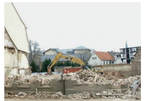
Steinbrücke 16 und 17 im Jahr 2003
