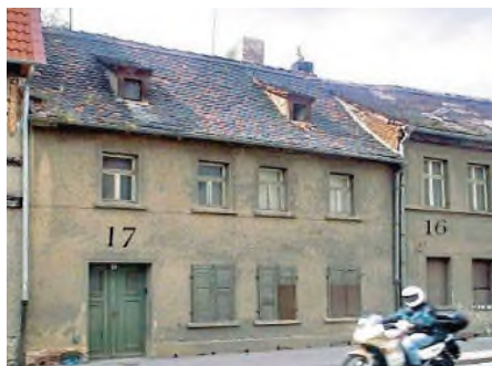
Steinbrücke 16 und 17 im Jahr 2002
