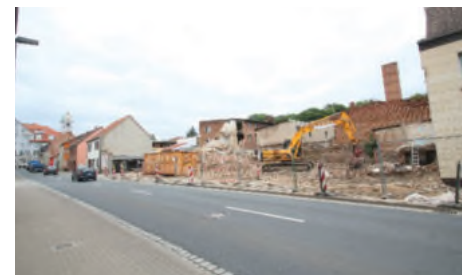
Großbaustelle im Jahr 2014
