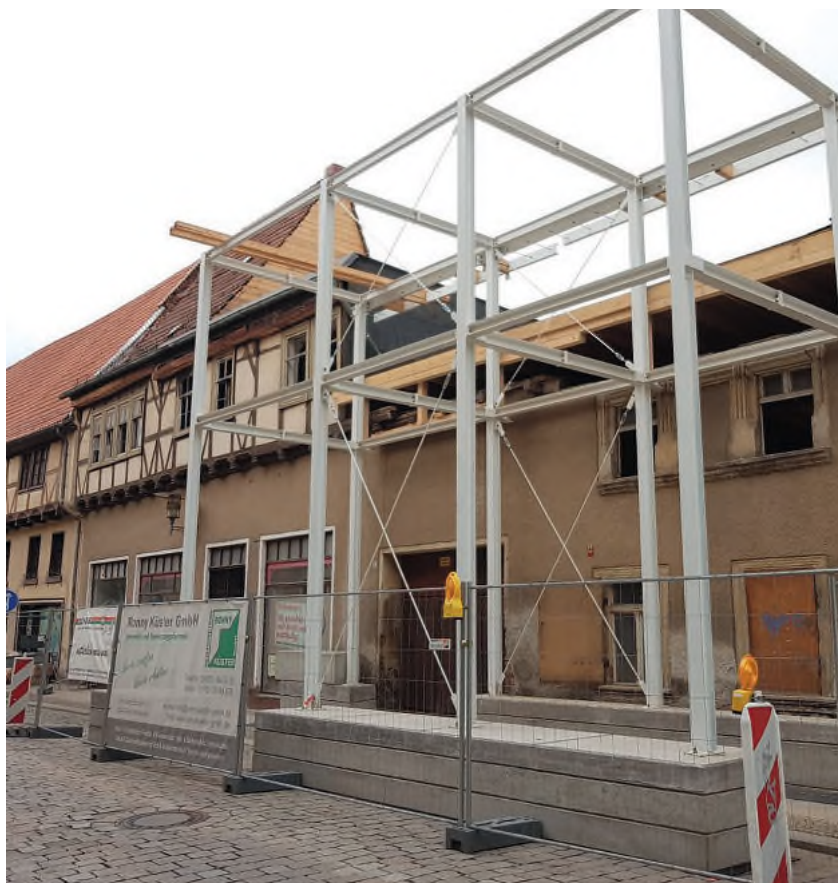
Großes Stahlgerüst an der Straßenfassade der Hohen Straße 21
