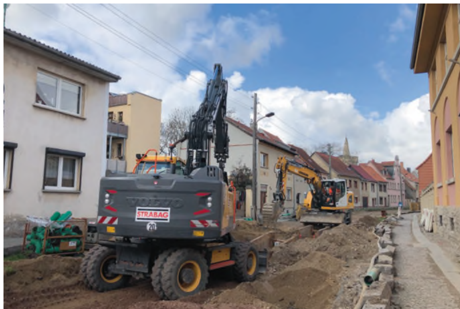
Seit April erfolgt der grundhafte Ausbau der Straße „Auf dem Graben“.
