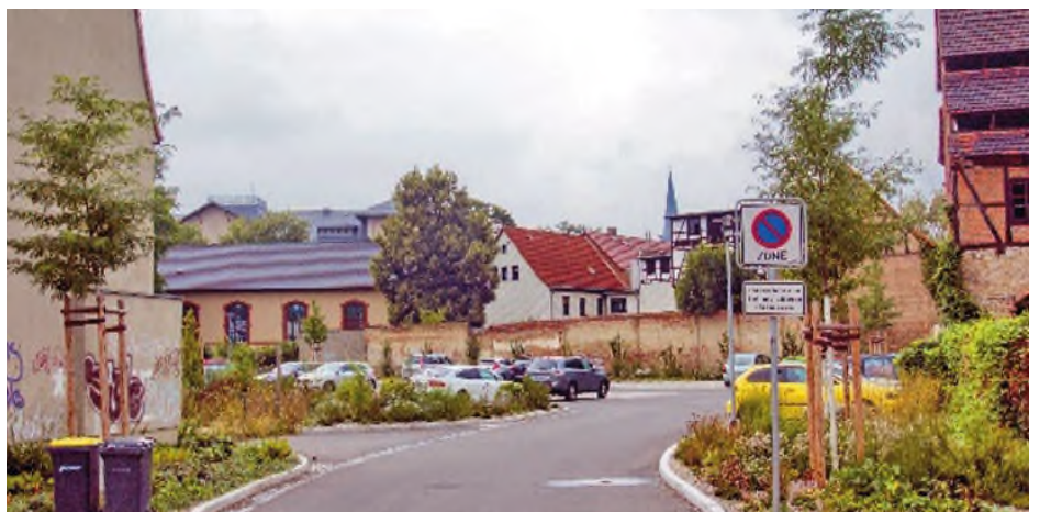
Auf der entstandenen Freifläche der Steinbrücke 16 und 17 entstand ein Parkplatz.
