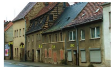
Steinbrücke 30 bis 34 im Jahr 2010
